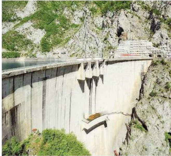
La diga. Un'immagine dell'impianto idroelettrico di Piva
