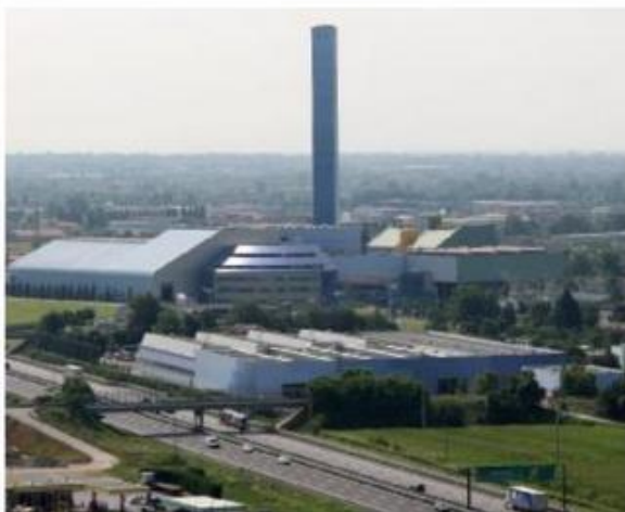
Il termovalorizzatore di A2A a Brescia è in funzione dal 1998
