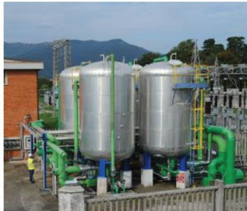
Il sistema di abbattimento del cromo esavalente ideato da A2A
