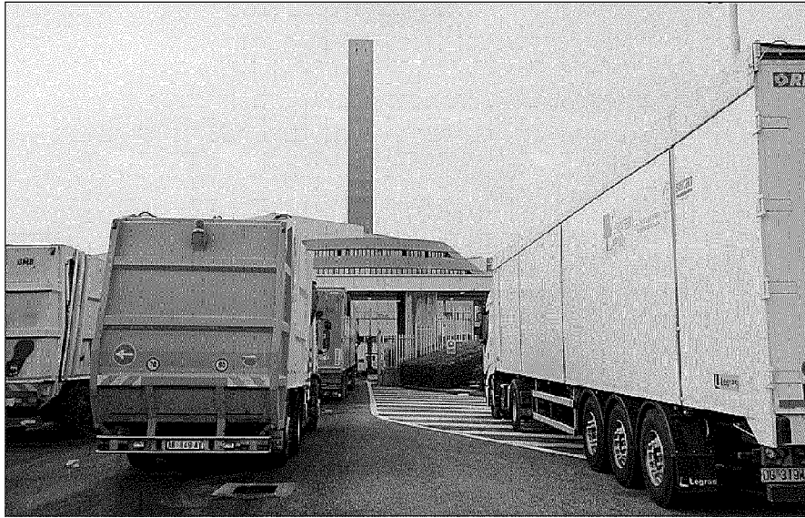
Nella foto d'archivio, camion diretti al termoutilizzatore di via Malta
