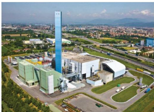
Il termovalorizzatore di A2A: sorge in via Codignole, nella periferia di Brescia
