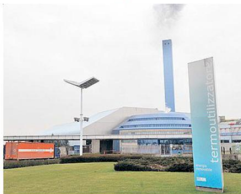
SOTTO ATTACCO L'esterno dell'impianto di termovalorizzazione di Brescia (Fotolive)
