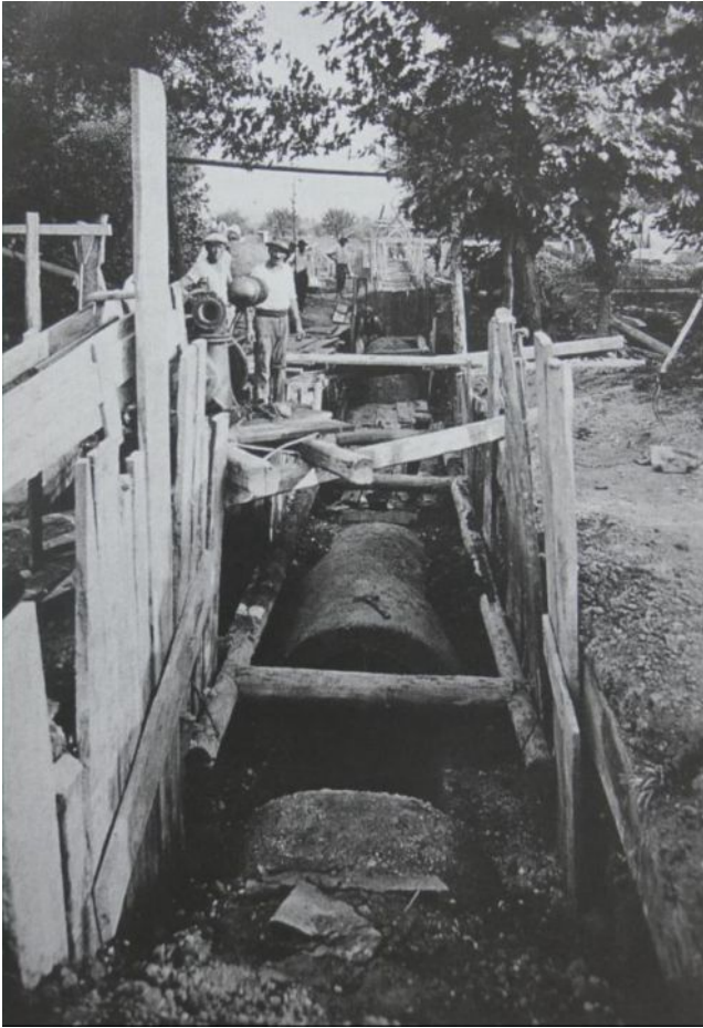
Come potete vedere questa è una costruzione di un emissario della fognatura di Brescia nel 1928.
