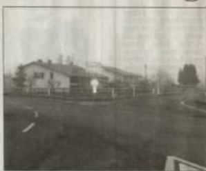
Lo svincolo della nuova strada statale 11
