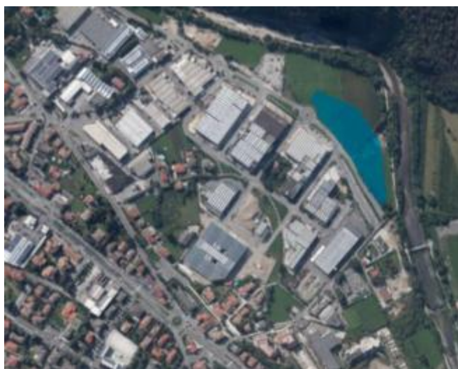
L'area dei cantieri vista dall'alto ed evidenziata in azzurro
