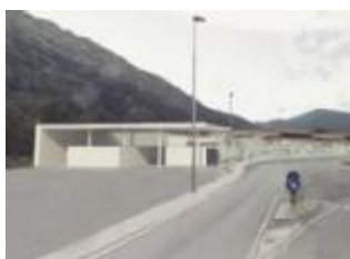
Il depuratore visto dal basso
