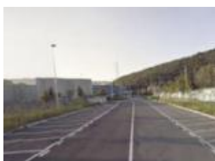
La zona di accesso e i parcheggi
